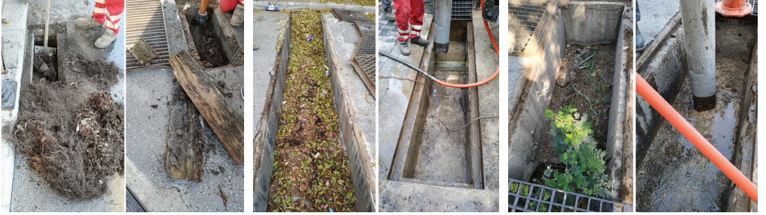
Yağmur suyu kanal temizliği
