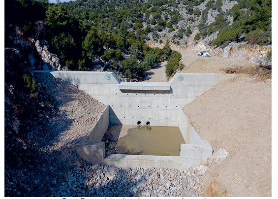
Gaz Deresi taşkın koruma çalışmaları
