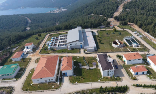
Güvercinlik adıtma tesisi
