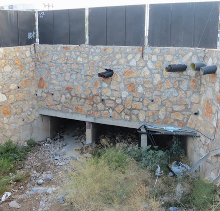
Gaz Deresi Bodrum-Turgutreis Karayolu menfez girişi
